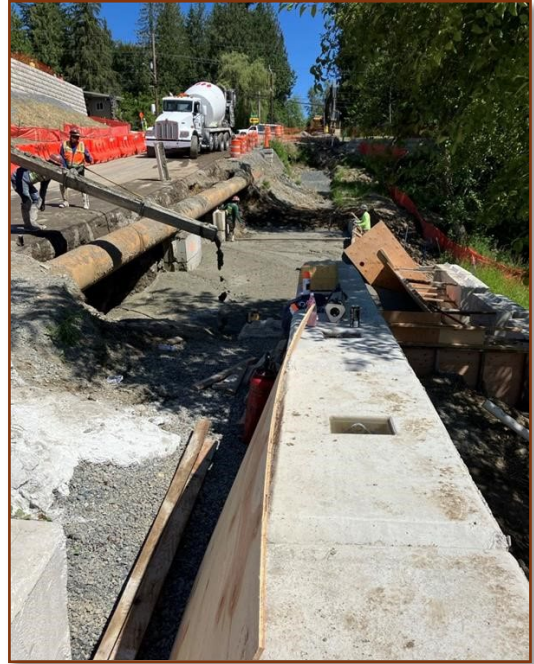
Fagerlie Subdivision Under Construction
